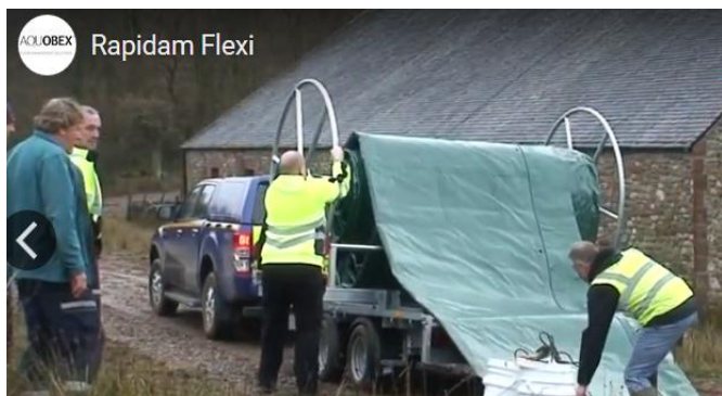
图 3 Rapidam Flexi 铺设现场
